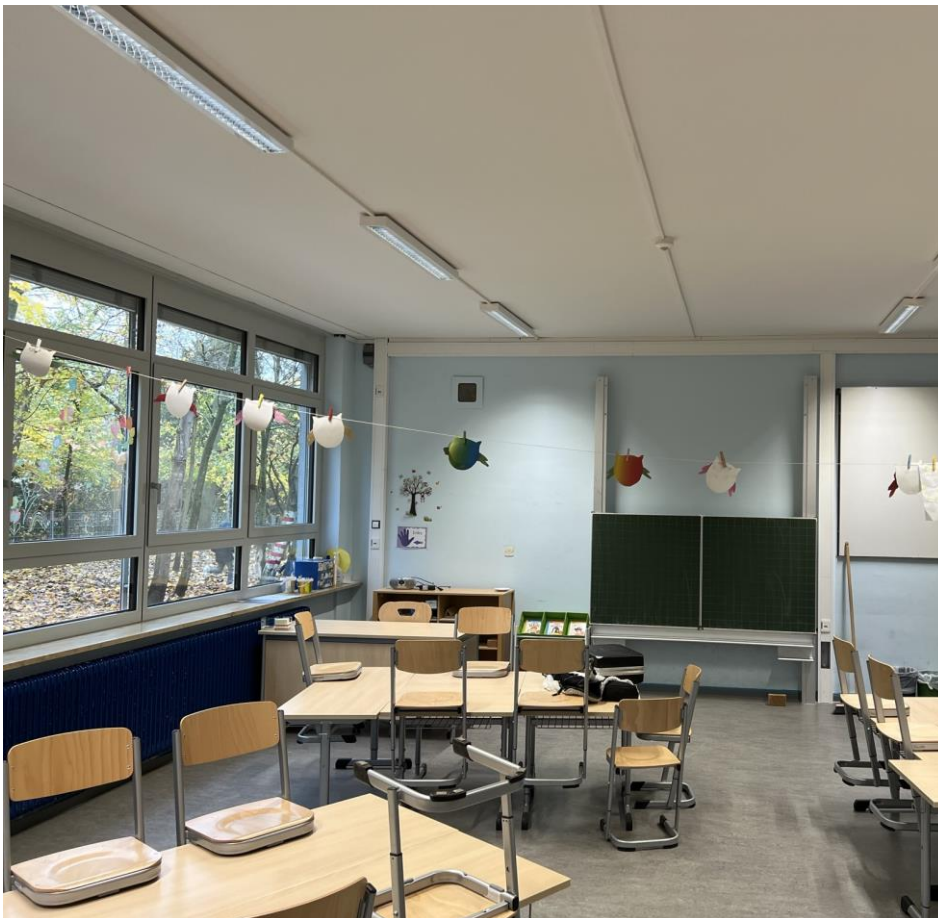
Abbildung 13: Klassenraum mit Installationskanälen Quelle: Eigene Abbildung
